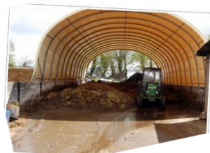
Figure 1: Stockage des effluents (Source : CA 12)
